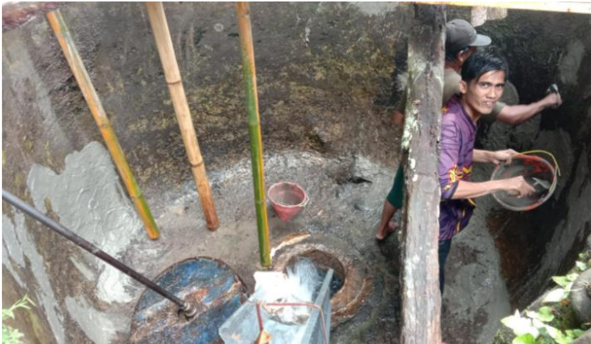
Gambar 7. Proses Mengubak Beton
