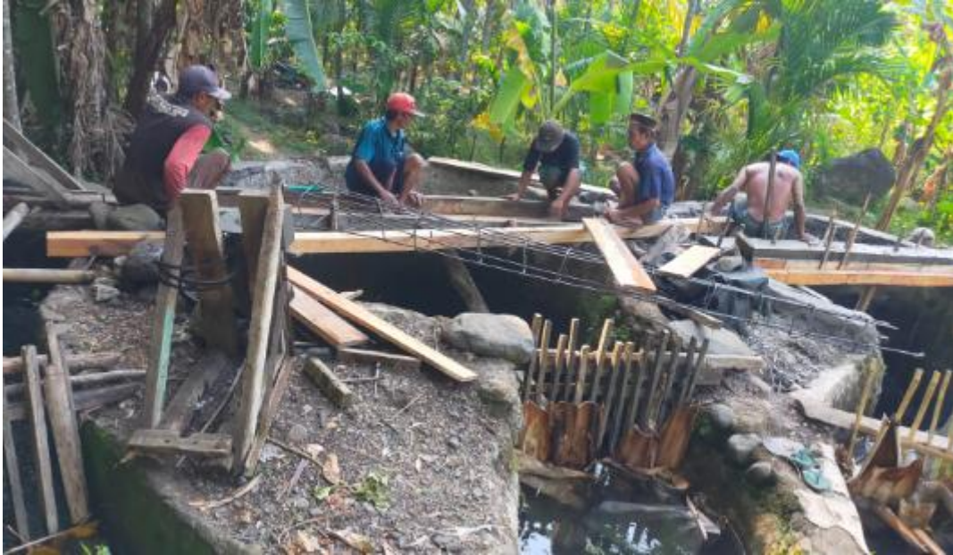
Gambar 6. Tahap Pengecoran Tempat Turbin
