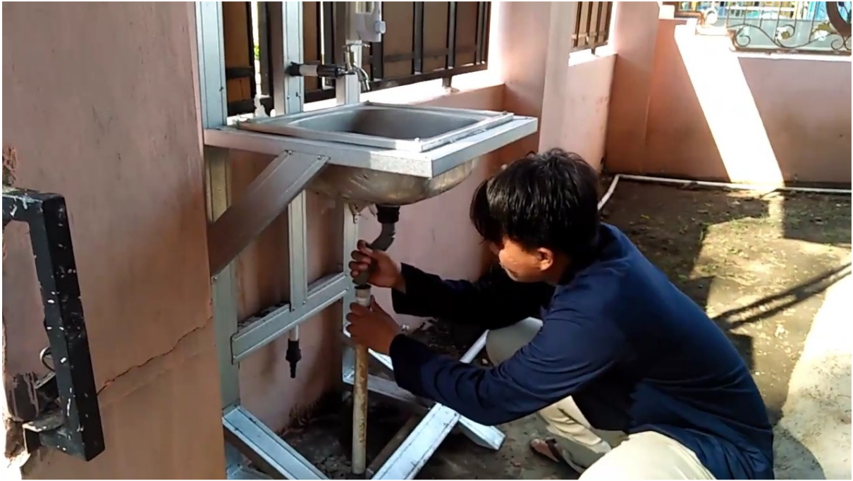
Pemasangan Pipa Pembuangan Pada Tempat Cuci Tangan
