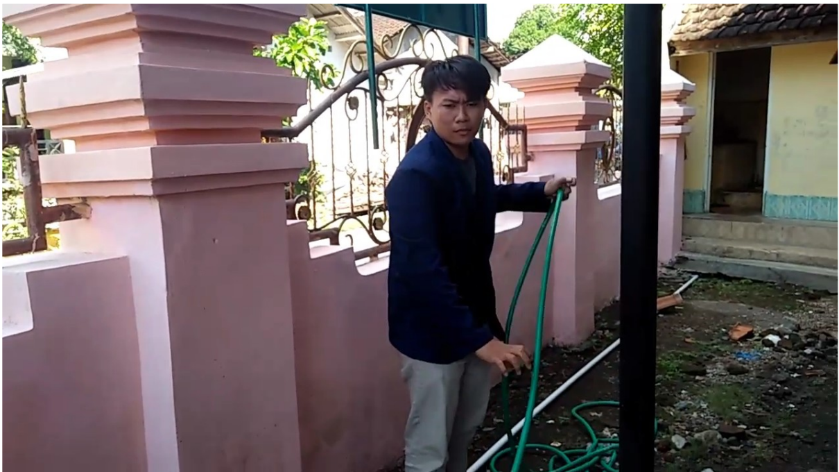
Pemasangan Selang Air Pada Tempat Cuci Tangan
