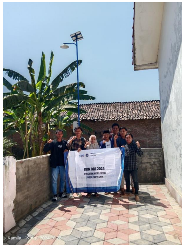
Gambar 8. Lampu Penerang jalan Untuk Warga Desa
