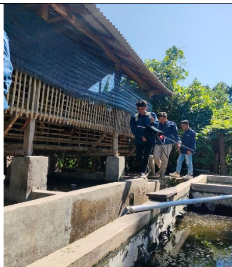
Survei pemasangan di kolam
